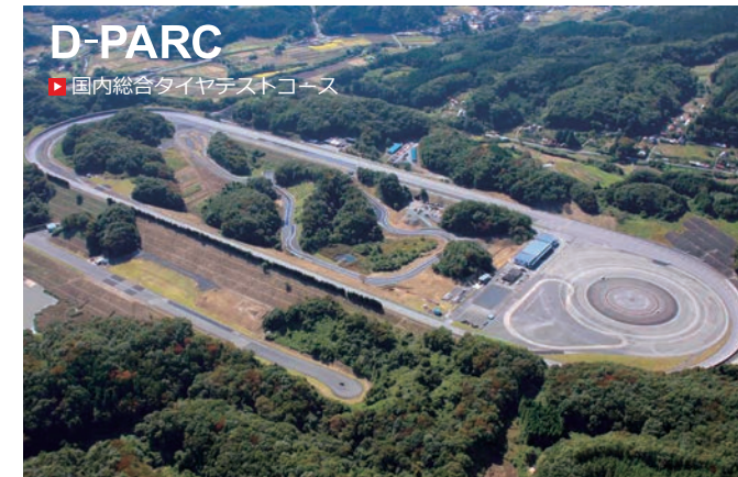
名 称 : D-PARC (Daigo Proving-ground and Research Center) 所 在 地 : 茨城県久慈郡大子町下金沢 695 番地
